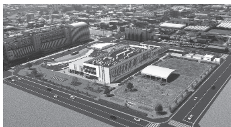
写真左：現在の東海キャンパス 写真中央：新棟完成イメージ
